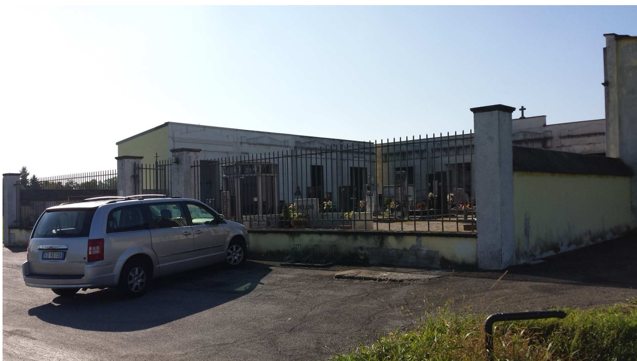
Cimitero di Castelnuovo – visione complessiva
