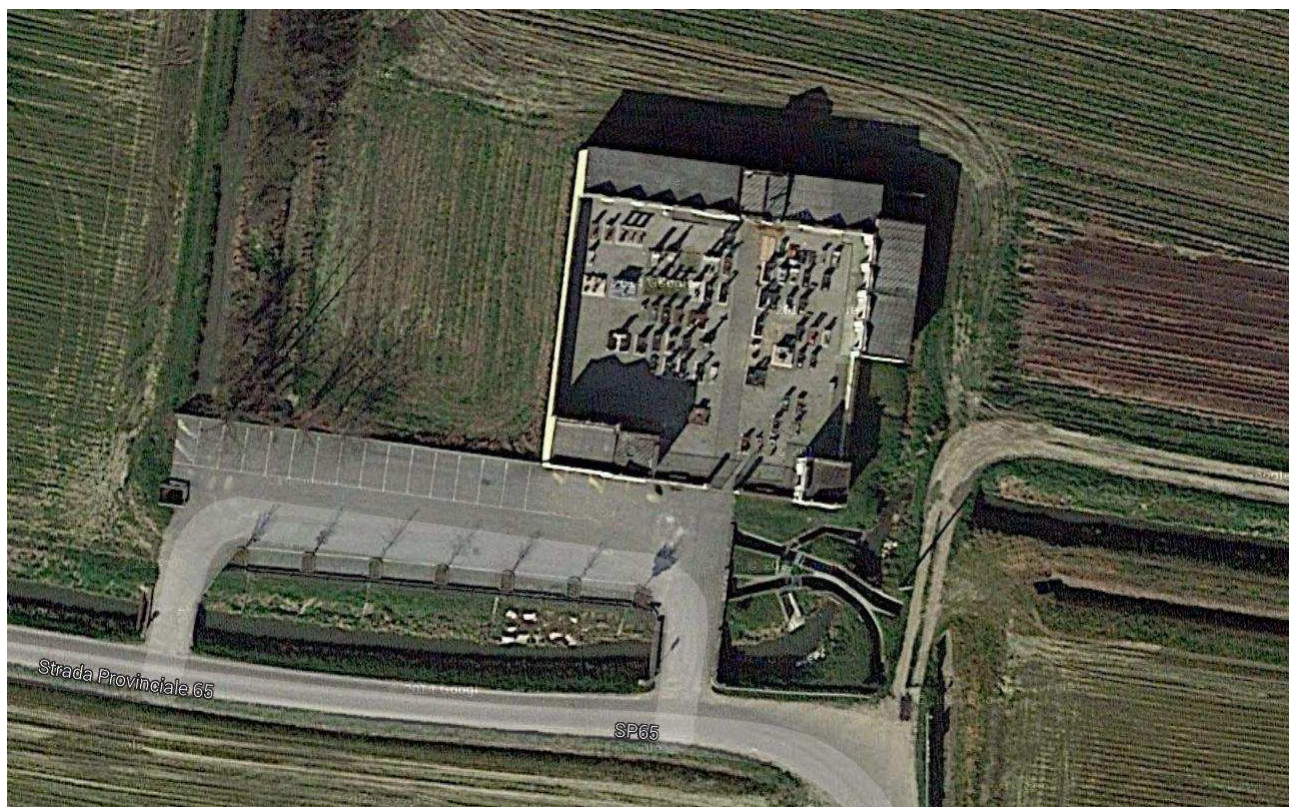
Cimitero di Pozzaglio capoluogo
